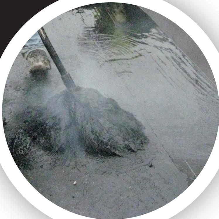
**L'Asphalte Easy-Melt Type 3 de IKO**, asphalte de catégorie supérieure, satisfait à toutes les exigences de la norme CSA A123.4-M, Type 3 ainsi qu'à celles de la norme UL 55A.
