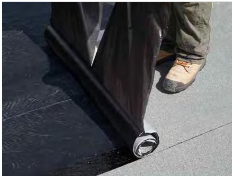
ArmourStickHD-Cap sont toutes deux fabriquées à partir d'une robuste armature composite non tissée, renforcée de fibres de verre sélectionnées et enduite de polymères SBS et d'asphalte de qualité supérieure. De robustes granules enrobés de céramique colorée protègent la surface de la membrane de finition.
