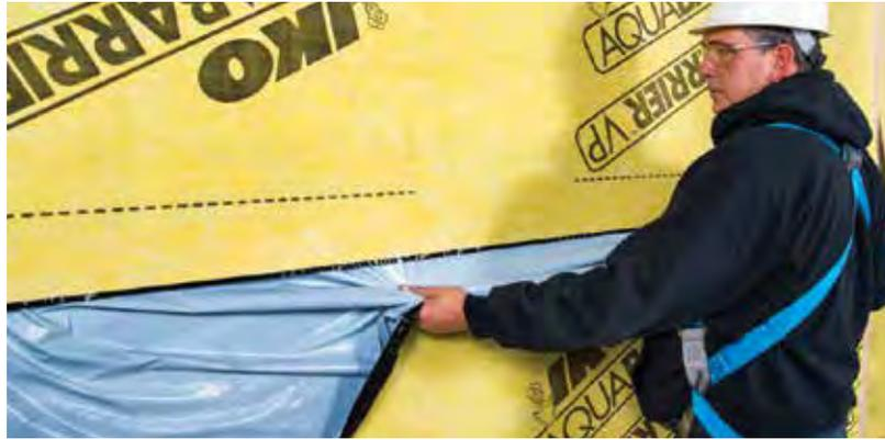
Le ruban IKO AquaBarrier VP complémente les rouleaux de membrane perméable à la vapeur AquaBarrier VP et l'isolant IKO Ener-Air® afin de former dans tout le système mural une barrière continue perméable à la vapeur et résistante à la moisissure.
