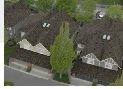
El sistema de techado de las casas adosadas Carrington - Braemore incluyó tejas asfálticas de diseño Armourshake en la hermosa Weathered Stone, que llevan una clasificación de resistencia al impacto de clase 3<sup>1</sup>.
