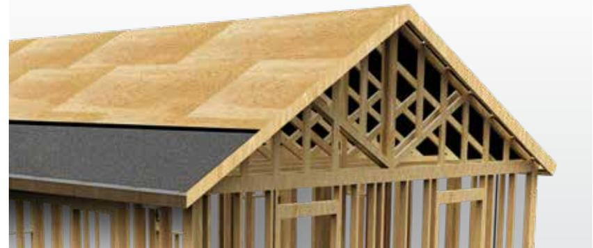
**Option 1 :****Étanchéifier le platelage avec la bande d'étanchéité de toiture et une sous-couche synthétique**
