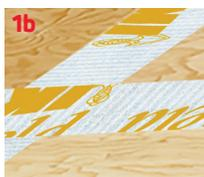
Utilisez le ruban d'étanchéité IKO GoldSeam pour étanchéifier les joints du platelage, là où les panneaux de contreplaqué ou OSB s'aboutent et qui doivent être correctement scellés. Une fois les joints bien rubanés, vous pouvez recouvrir le platelage avec la sous-couche synthétique de IKO. N'oubliez pas d'utiliser le protecteur contre la glace et l'eau de IKO dans les zones où le code l'exige.
